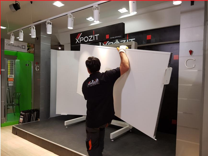
Panourile ultrausoare sunt instalate cu usurintate pe structura metalica existenta.
