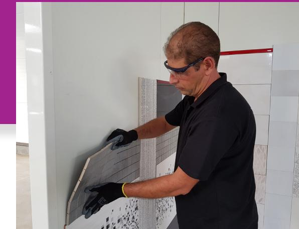
Ultimele placi sunt aplicate - sistemul functioneaza cu toate formele. In imagine, muncitorul instaleaza placi de mozaic.
